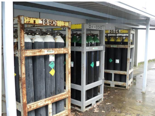
Almacenamiento gases soldadura
