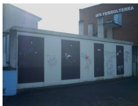
Centro de transformación
