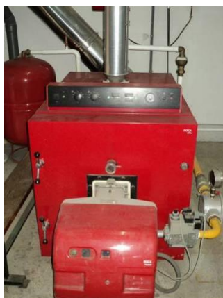
Sala de Calderas Edificio Talleres
