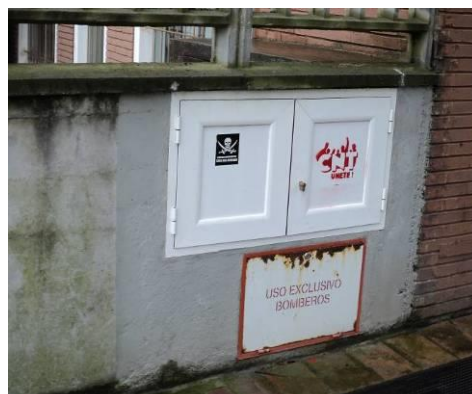
Toma de fachada uso bomberos
