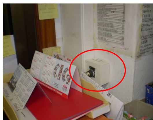
Llave activación alarma incendios
