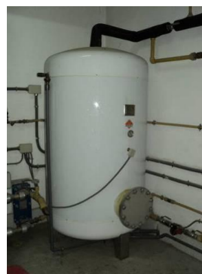
Acumulador caldera talleres
