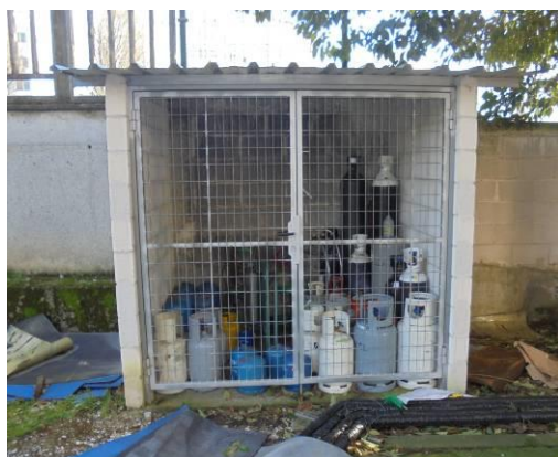
Almacén de gases exterior
