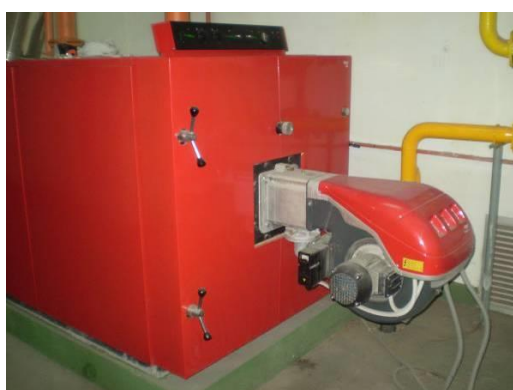
Caldera Edificio Principal
